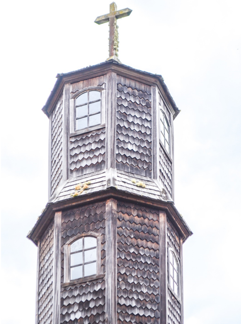
Figura 4: Torre de la iglesia San Antonio de Colo, Chiloé. Fotografía: Isidora Ayala C. (2020).
